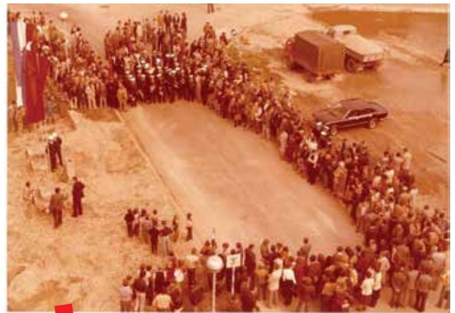
Polaganje kamena temeljca, 1979.
