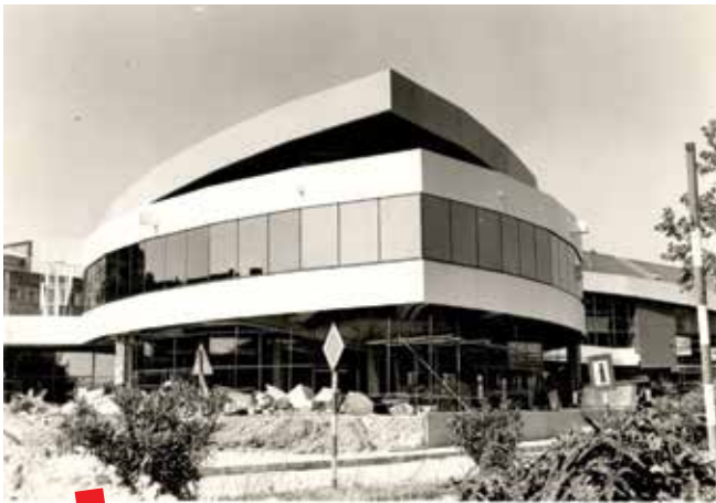
Radovi na izgradnji, 1980.
